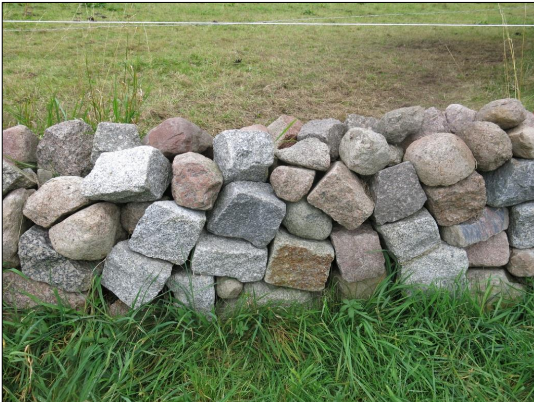
Abb. 4: Mauer im südöstlichen Grenzbereich des Flurstücks 18/1
